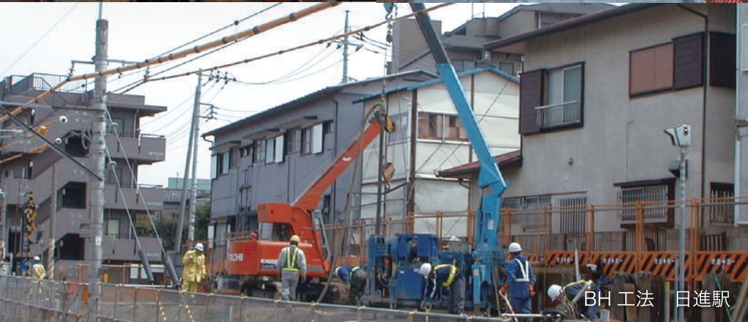
リバース工法 新古河線No93他基礎補強工事
