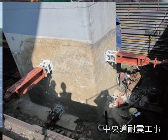
荒川橋脚耐震補強工事
